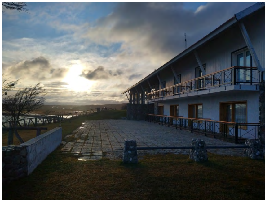
Imagen 34: Hostería Kaiken, construida en la década de 1960 en la cabecera este del lago Fagnano-Kahmy.
