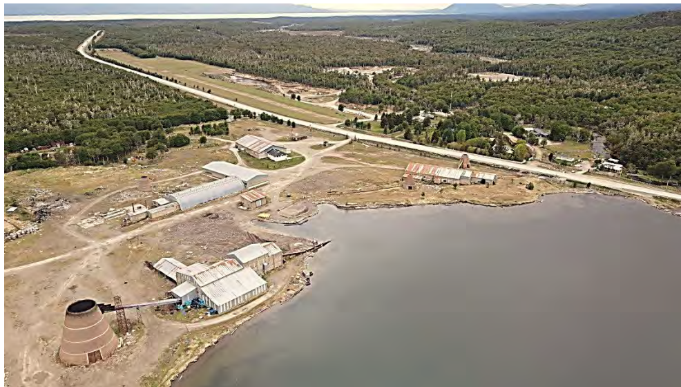
Imagen 23: Vista aérea del aserradero Bronzovich en la cabecera norte del lago Escondido, que estuvo activo entre la década de 1970 y la de 2010.
